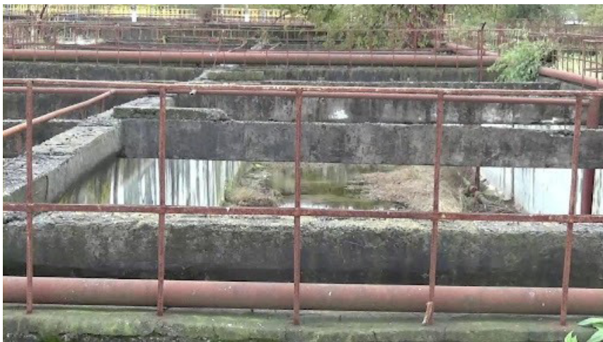
Неработающие аэротенки ОСК-2 рядом с Владикавказом.
